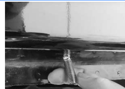
(Fig 3c) Insert (1) M10 J-Bolt
